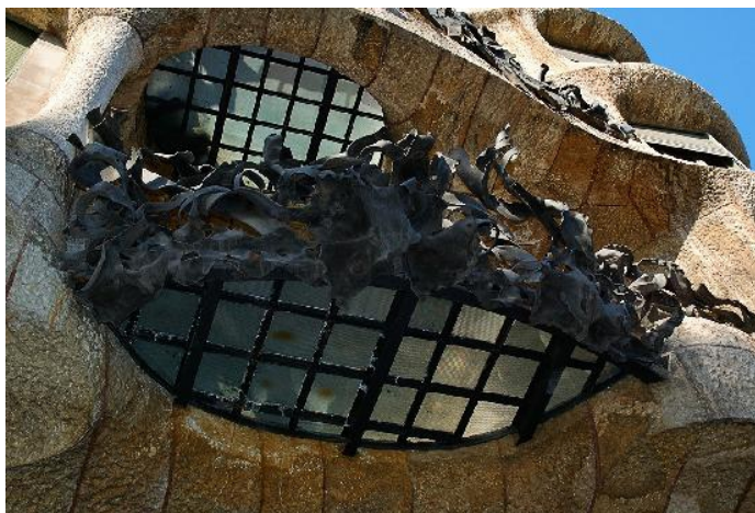
Illustrazione 5: Balconi di Casa Milà caratterizzati da pavimentazione in vetro battuto e ringhiere in ferro battuto.
